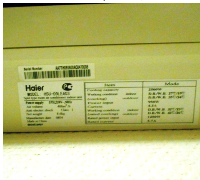
5б. Система кондиционирования К6, табличка
