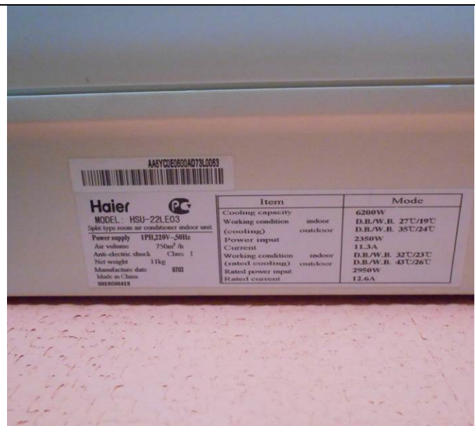
4б. Система кондиционирования К5, табличка
