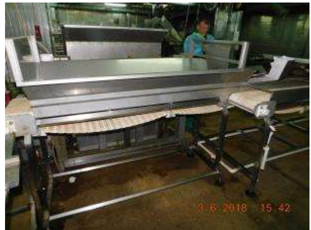
Фото 150. Конвейер приемный с бортами
