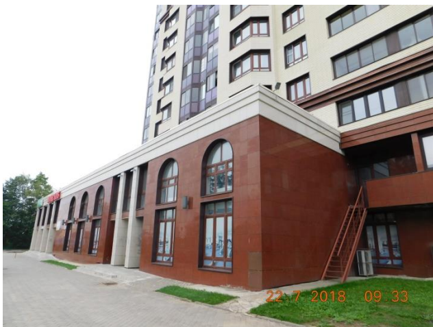
Внешний вид здания
