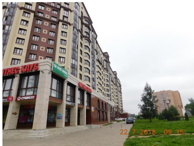
Внешний вид здания
