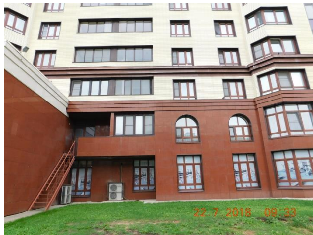
Внешний вид здания
