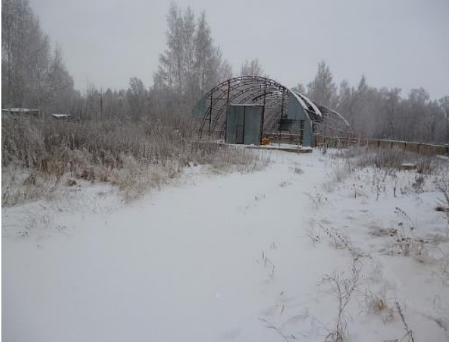
Пристрой к складу площадью 232,1 кв.м.
