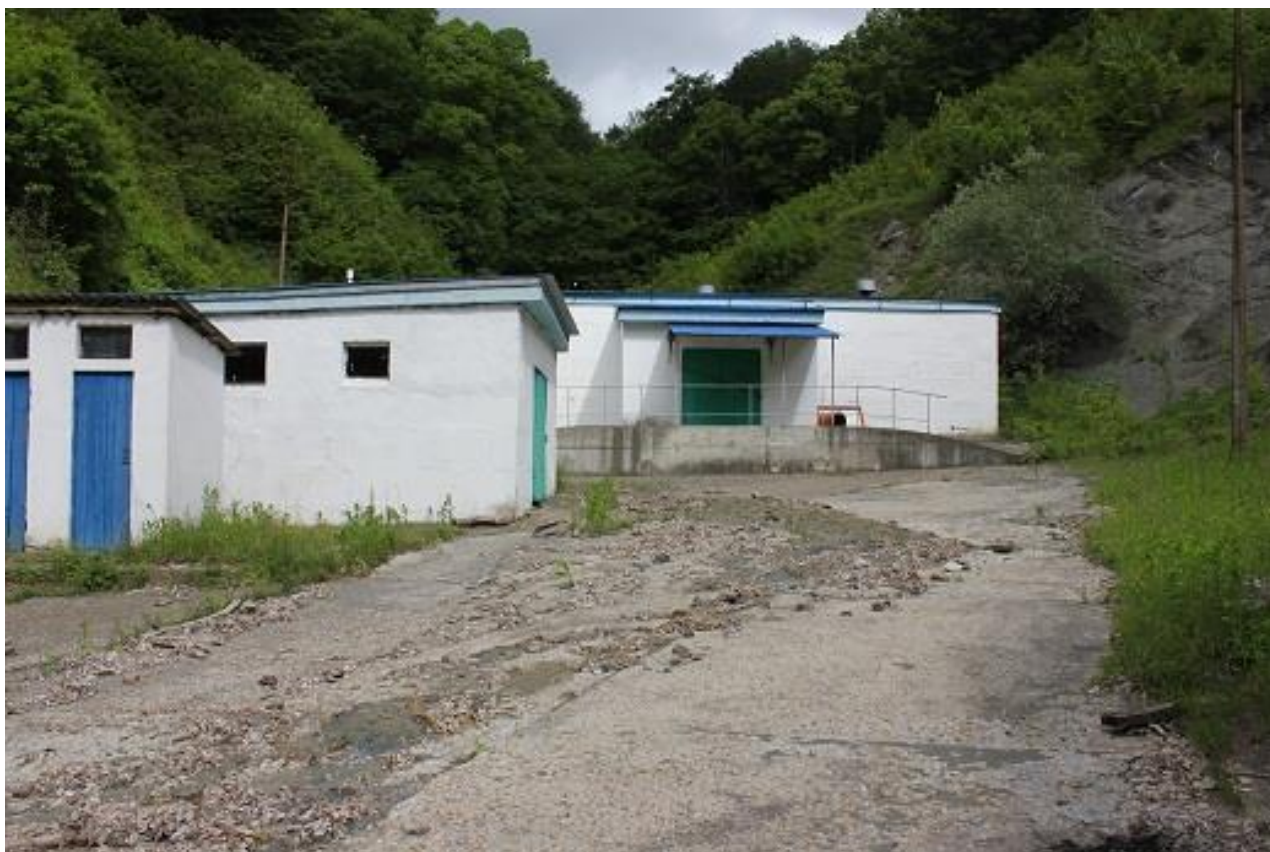
Фото 19. Хранилище взрывчатых веществ, литер И
