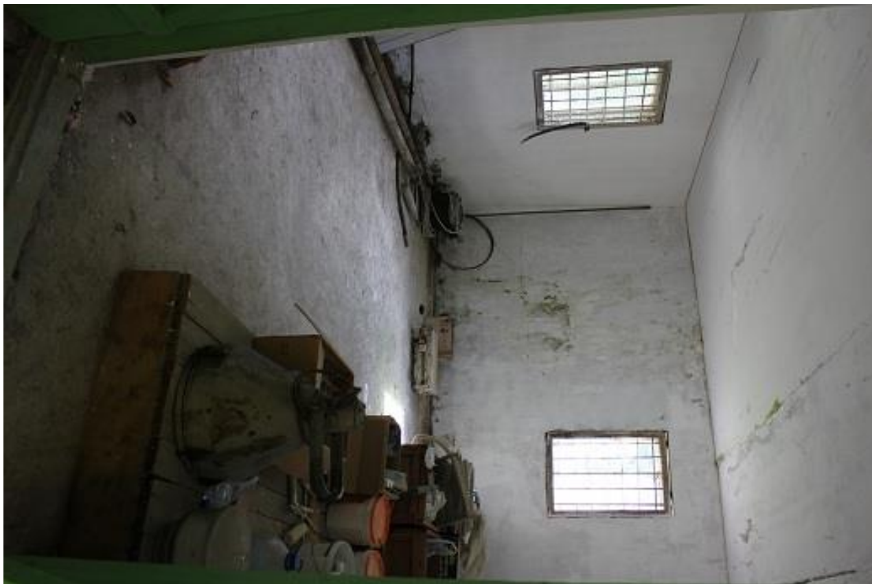
Фото 13. Противопожарное хранилище, литер 3
