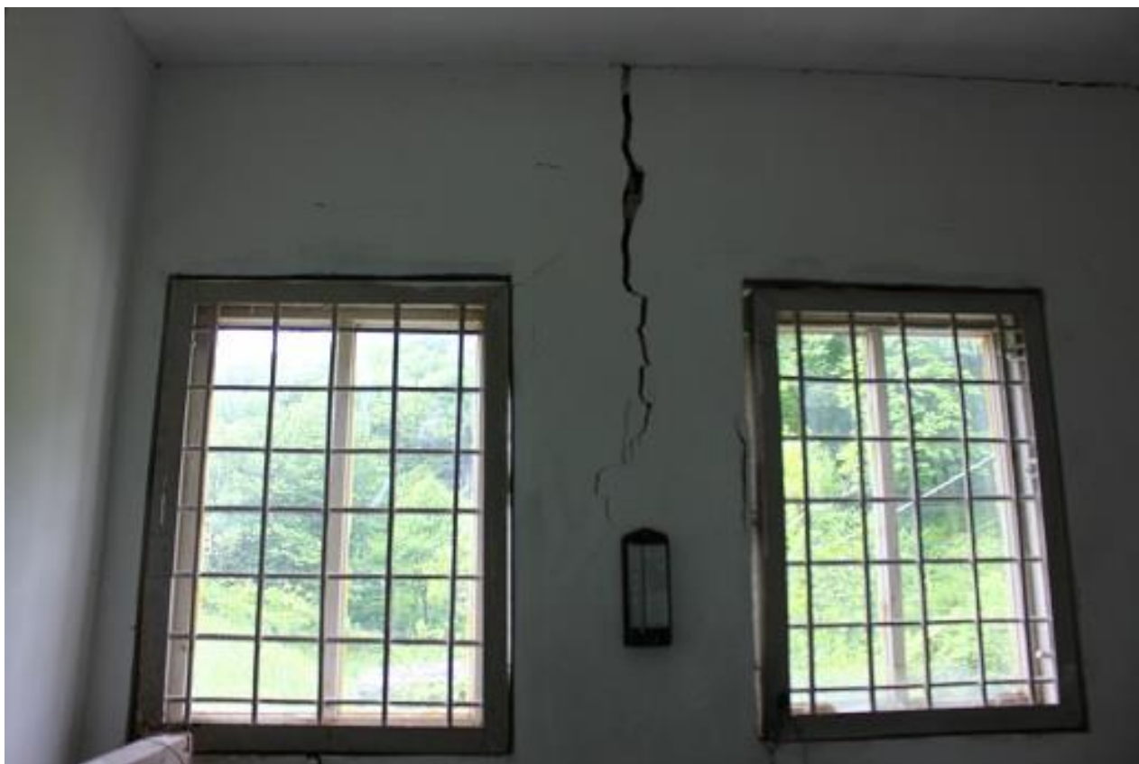
Фото 15. Противопожарное хранилище, литер З
