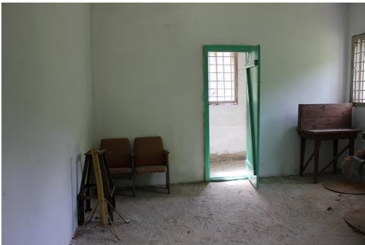
Фото 14. Противопожарное хранилище, литер 3
