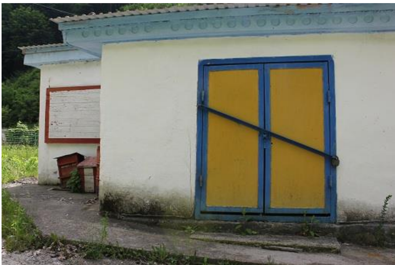
Фото 12. Противопожарное хранилище, литер З
