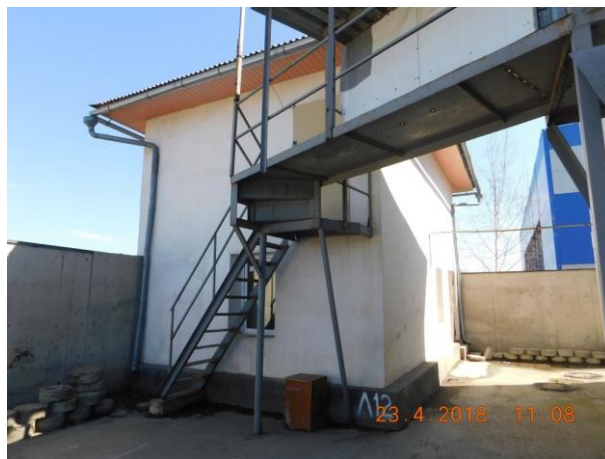
Сооружение 2х эт. бытовое кирпичное
