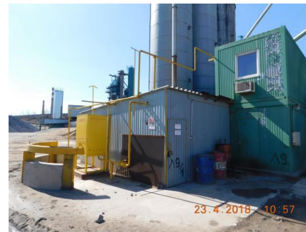
Сооружение Асфальто-смесительная установка "Teltomat 240"
