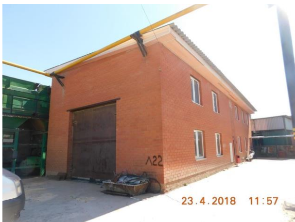
Сооружение 2х эт.кирпичное
