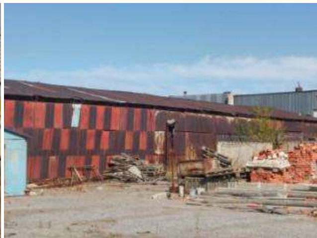
Рисунок 7.16. Промплощадка МЦАк ООО НВЭМ
