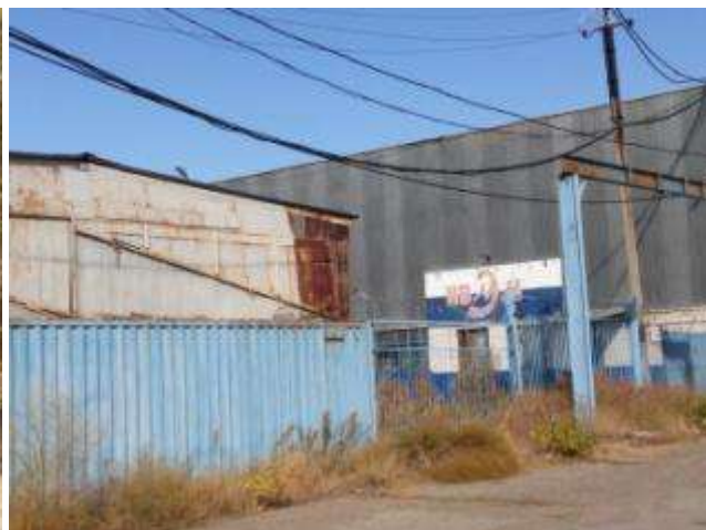
Рисунок 7.18. Промплощадка МЦАк ООО НВЭМ
