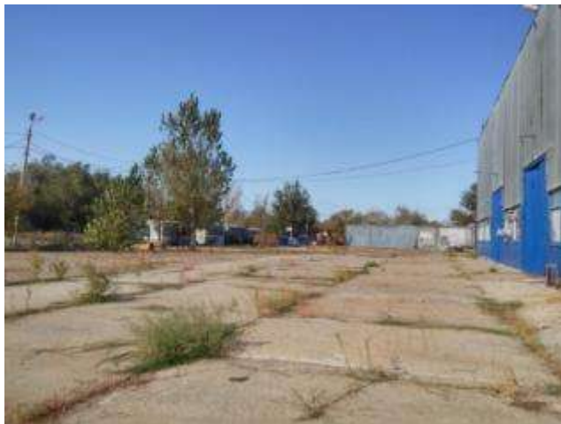
Рисунок 7.11. Промплощадка МЦАк ООО НВЭМ
