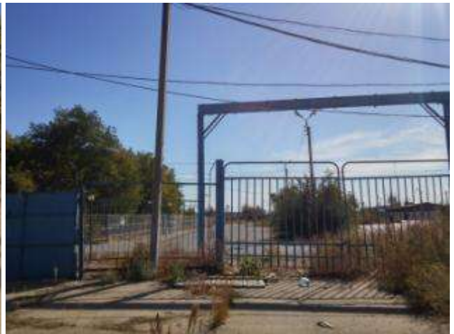
Рисунок 7.10. Промплощадка МЦАк ООО НВЭМ
