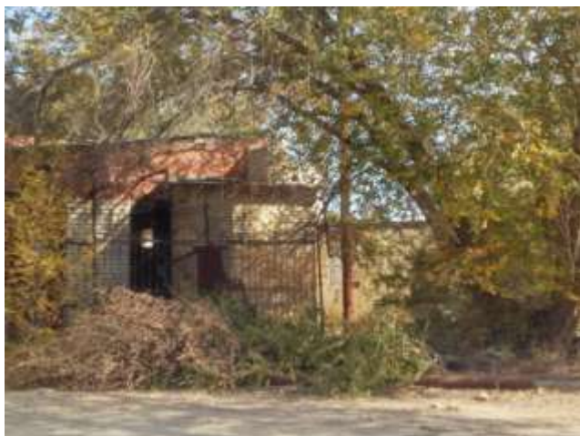
Рисунок 7.17. Промплощадка МЦАк ООО НВЭМ
