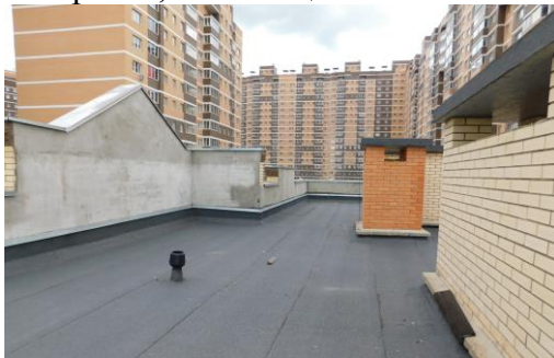
23. Кровля, вентиляционные вытяжки
