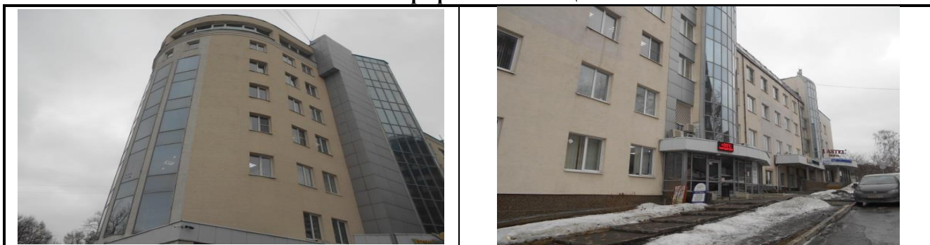
Общий вид здания по адресу: Екатеринбург, ул. Бажова, д.193
