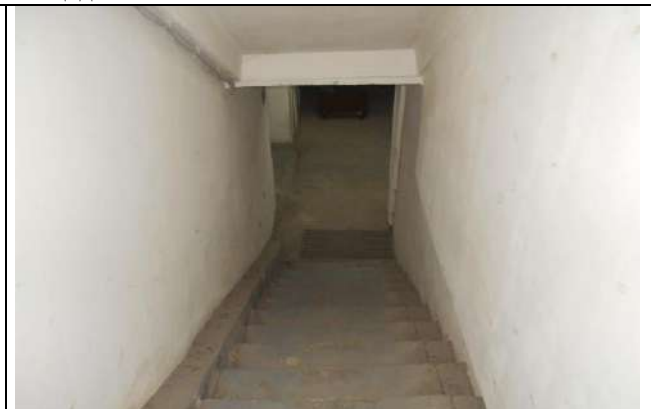
Лестница в подвал
