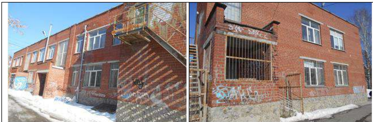
Административное здание, по адресу: Екатеринбург, ул. Александровская, д. 3-а
