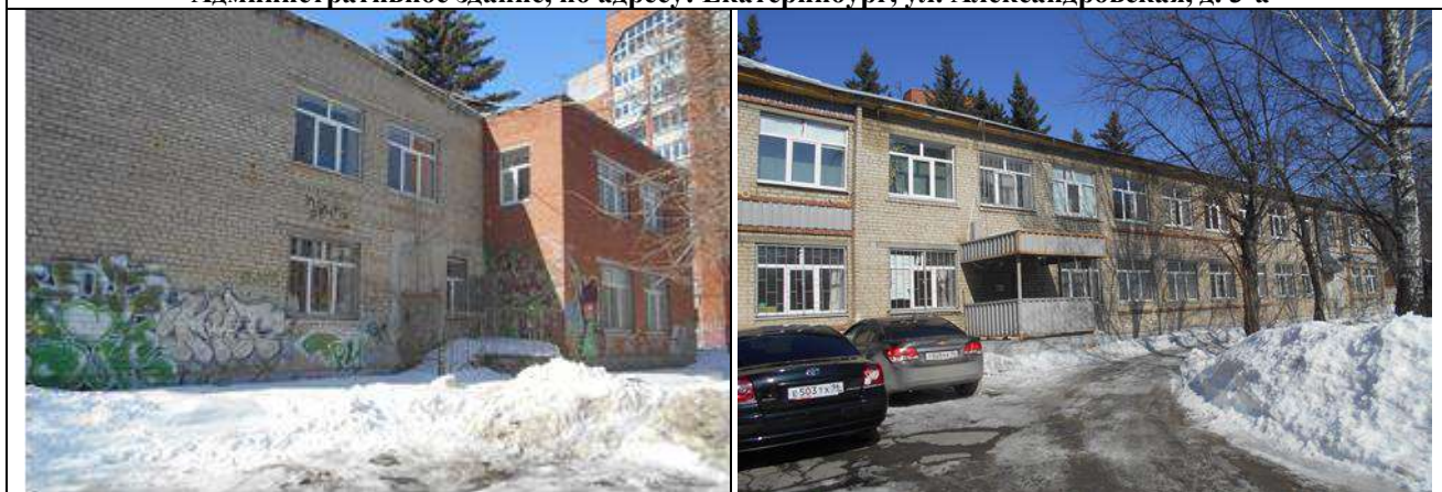
Административное здание, по адресу: Екатеринбург, ул. Александровская, д. 3-а
