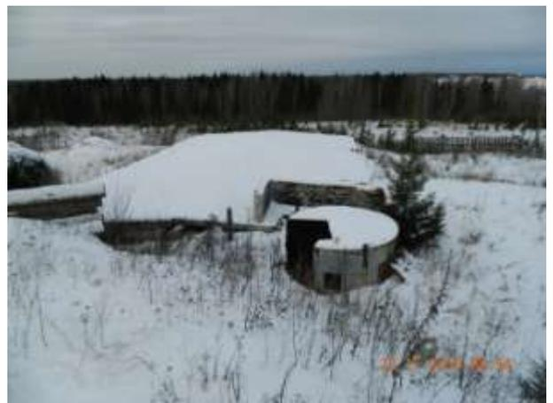
Фото 7.2 Здание битумохранилища из железобетонных плит общей площадью 205,5 кв. м
