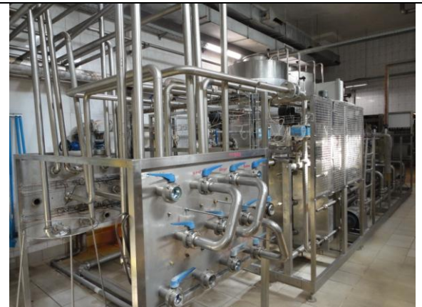
94. Установка мойки CIP-модуль ЛМ5-Ц (СИП-мойка)
