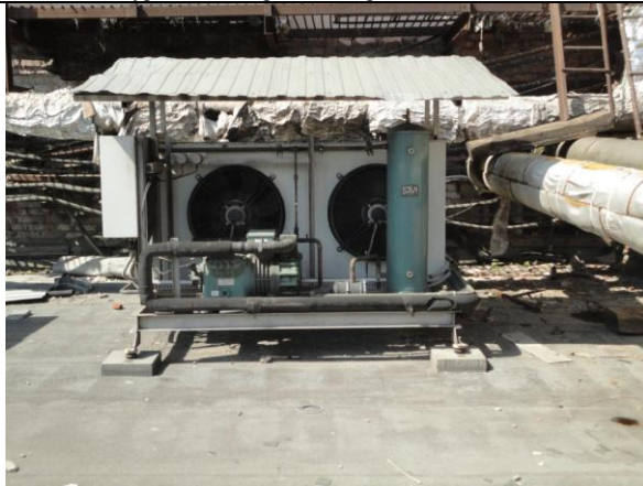
43. Компрессорно-конденсаторный агрегат АК-ВК-100/2.6/4Н-25.2У/Р60
