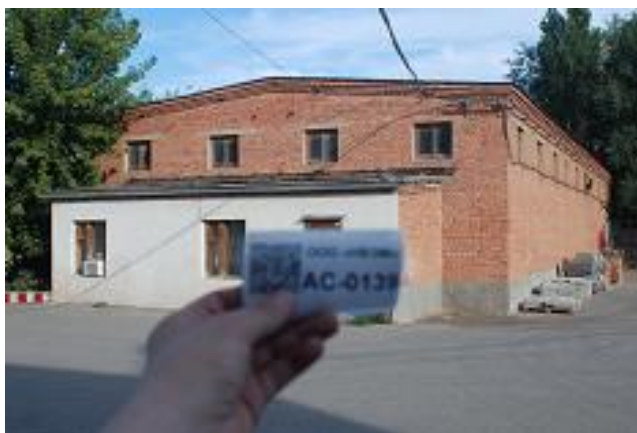
Рисунок 7.1. Склад, назначение: нежилое. Площадь: общая 377,50 кв.м. Литер: Д. Этажность:1. Условный номер: 30-01/01-64/2002-0081. Запись в ЕГРП: 30-01/01-64/2002-0081 от 26.11.2006. Кадастровый номер: 30:12:021133:139.
