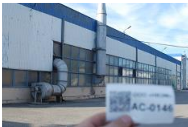
Рисунок 7.8. Монтажно-заготовительный участок, назначение: нежилое. Площадь: общая 1 533,80 кв.м. Инвентарный номер: 12:401:002:000176690:0200:20000. Литер:Б. Этажность:1. Условный номер: 30-01/01-64/2002-0078. Запись в ЕГРП: 30-01/01-64/2002-0078 от 26.11.2006. Кадастровый номер: 30:12:021133:147.
