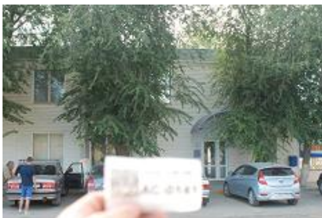
Рисунок 7.3. Административно-бытовой корпус, назначение: нежилое. Площадь: общая 429,20 кв.м. Инвентарный номер: 12:401:002:000176690:0700:20000. Литер: Ж. Этажность: 2. Условный номер: 30-01/01-64/2002-0083. Запись в ЕГРП: 30-01/01-64/2002-0083 от 26.11.2006. Кадастровый номер: 30:12:021133:142.
