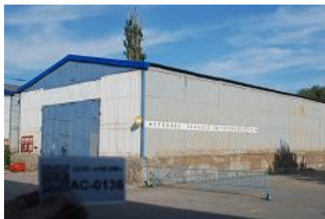
Рисунок 7.4. Склад, назначение: нежилое. Площадь: общая 440,40 кв.м. Литер: Г. Этажность:1. Условный номер: 30-01/01-64/2002-0080. Запись в ЕГРП: 30-01/01-64/2002-0080 от 26.11.2006. Кадастровый номер: 30:12:021133:143.
